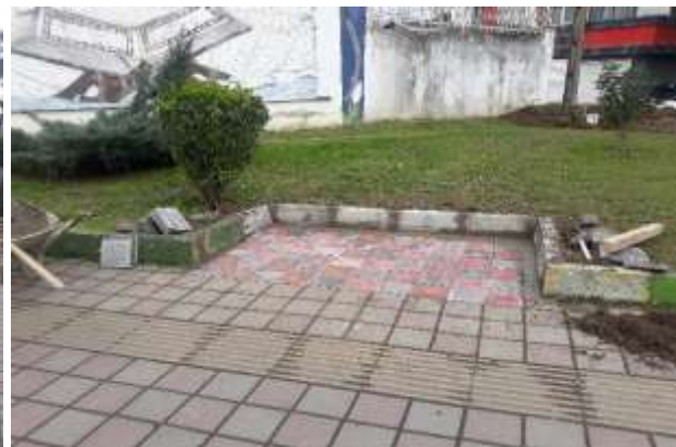
عکس بعد از اجرا
