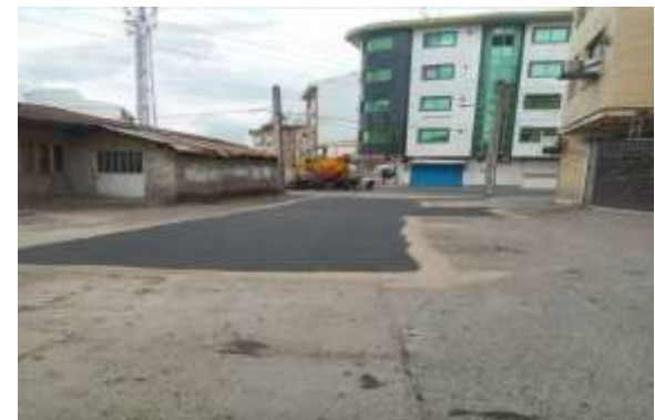
عکس بعد از اجرا
