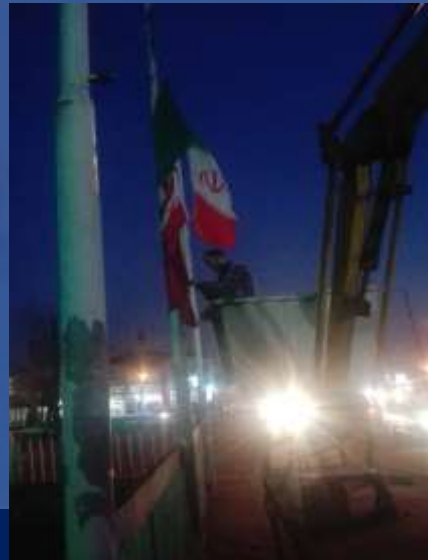
نصب پرچم آسیب دیده پل یخساز
