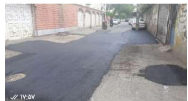
عکس بعد از اجرا
