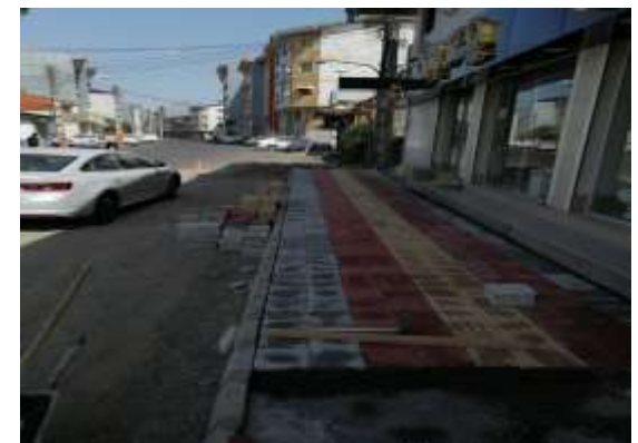
عکس بعد از اجرا
