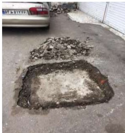
عکس قبل از اجرا
