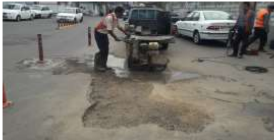
عکس قبل از اجرا
