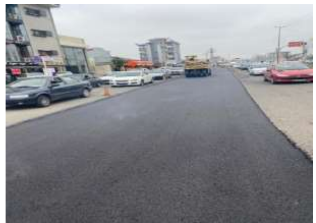
عکس بعد از اجرا
