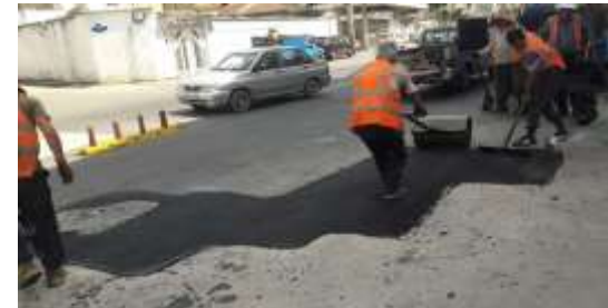
عکس بعد از اجرا
