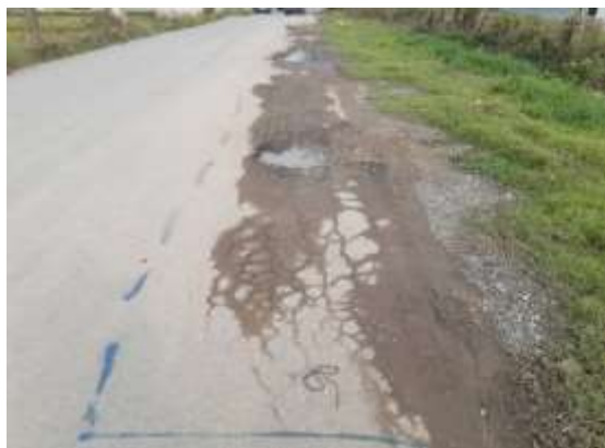
عکس قبل اجرا
