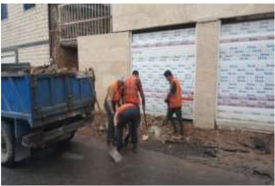
عکس قبل از اجرا
