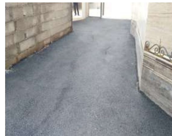
عکس بعد از اجرا
