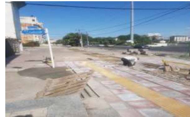
عکس بعد از اجرا
