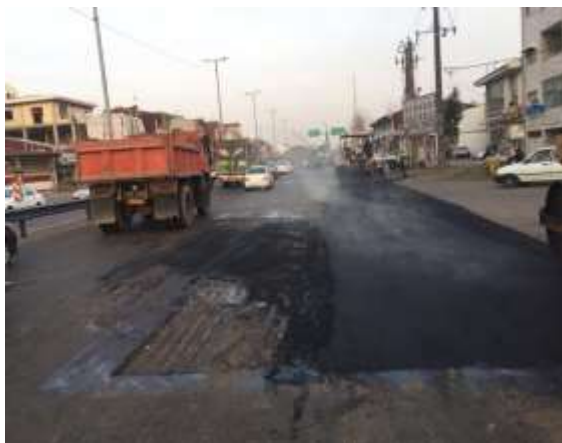
عکس قبل اجرا
