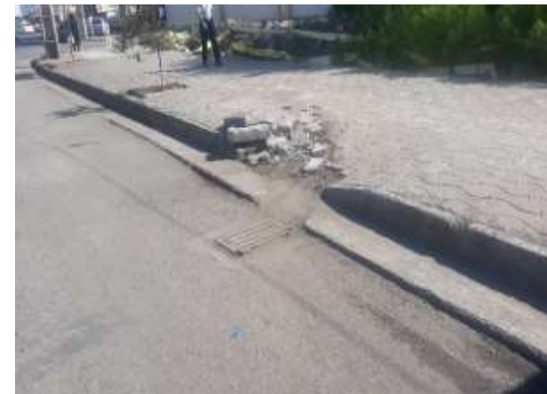
عکس بعد از اجرا
