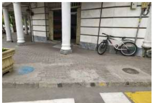
عکس قبل از اجرا
