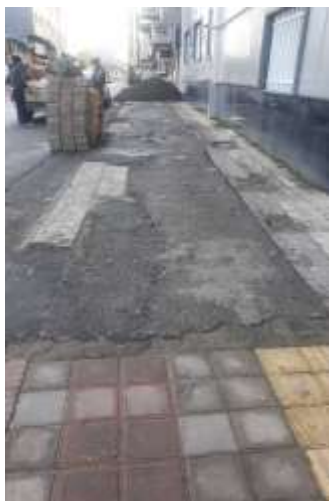
عکس قبل از اجرا
