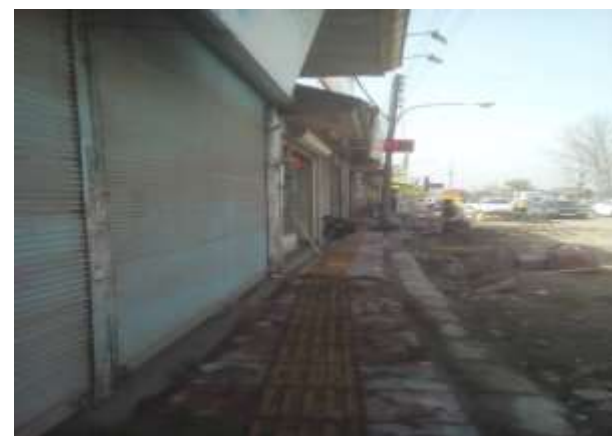
عکس بعد از اجرا
