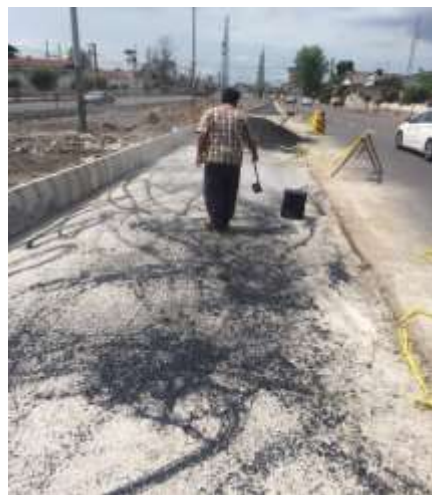
عکس قبل اجرا
