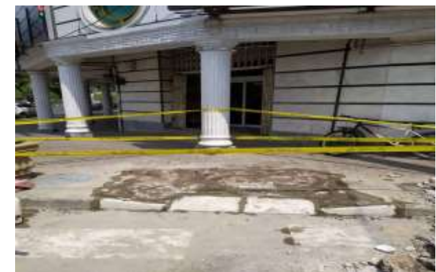
عکس بعد از اجرا
