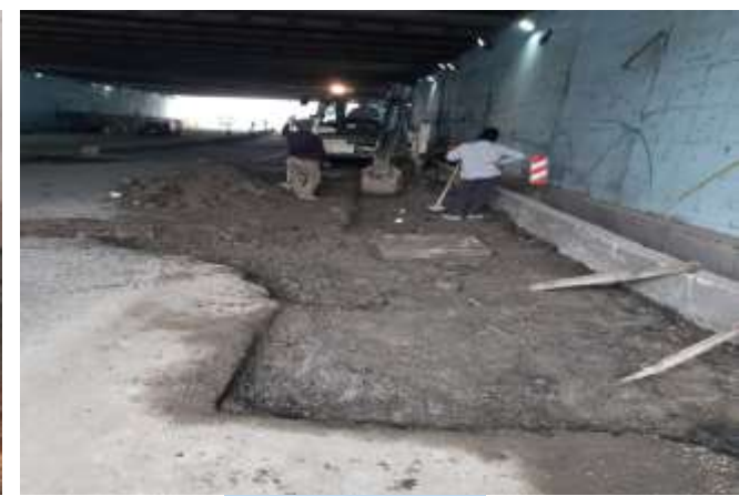
عکس بعد از اجرا
