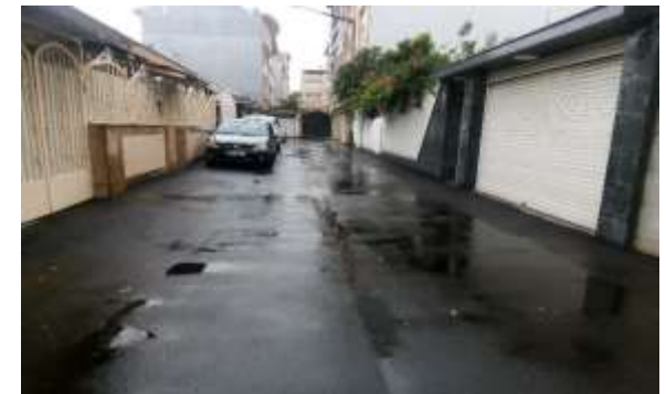
عکس بعد از اجرا
