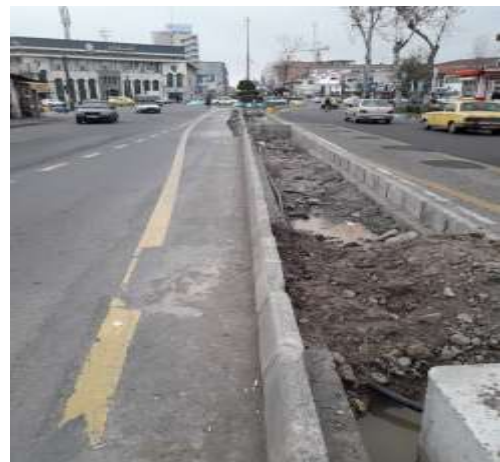
عکس بعد از اجرا
