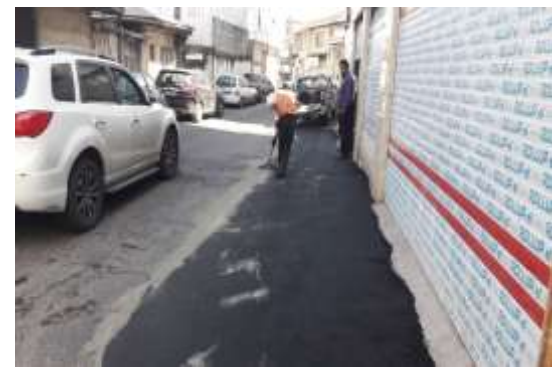
عکس بعد از اجرا
