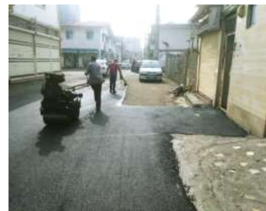
عکس بعد از اجرا
