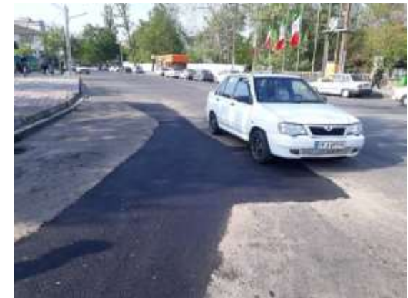
عکس بعد از اجرا
