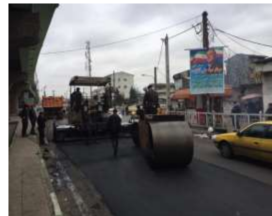
عکس بعد از اجرا
