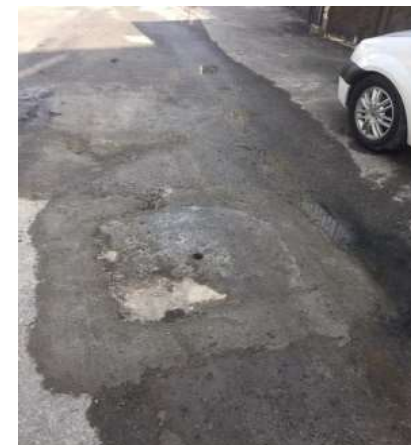
عکس بعد از اجرا
