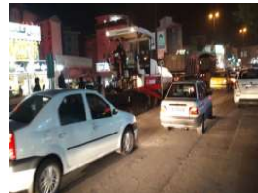
عکس بعد از اجرا
