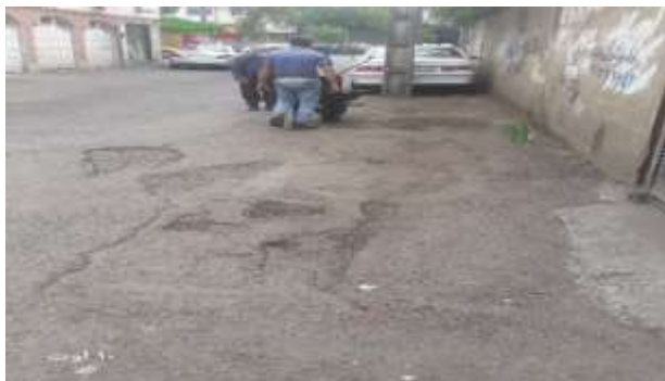
عکس قبل از اجرا
