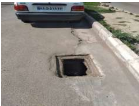
عکس قبل از اجرا
