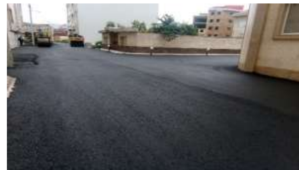
عکس بعد از اجرا
