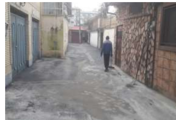
عکس بعد از اجرا
