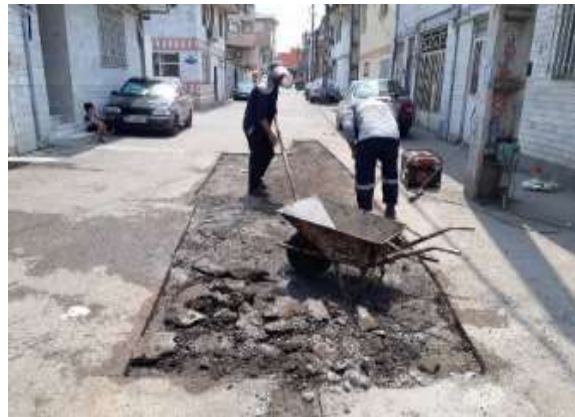
عکس قبل از اجرا
