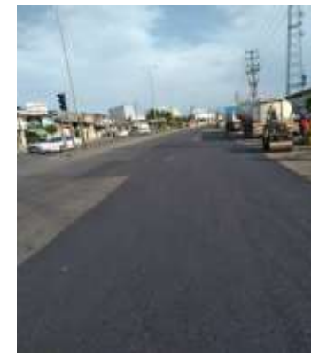
عکس بعد از اجرا
