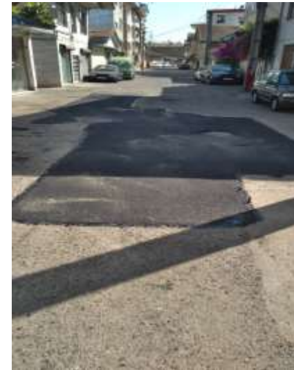
عکس بعد از اجرا
