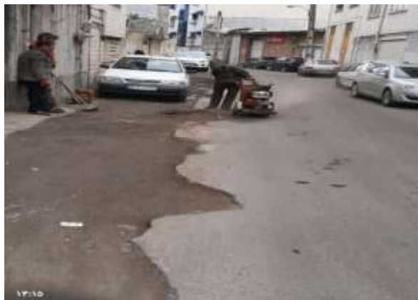
عکس قبل از اجرا
