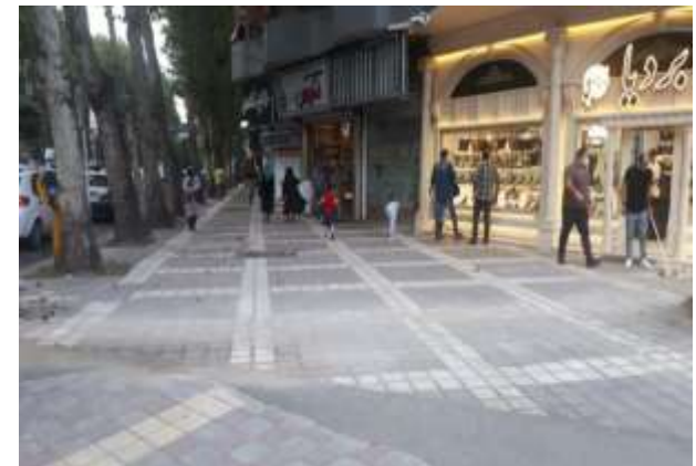
عکس بعد از اجرا
