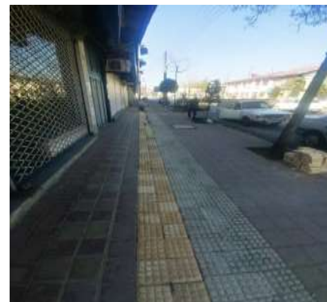
عکس بعد از اجرا
