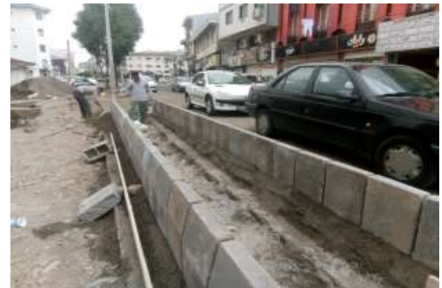
عکس بعد از اجرا
