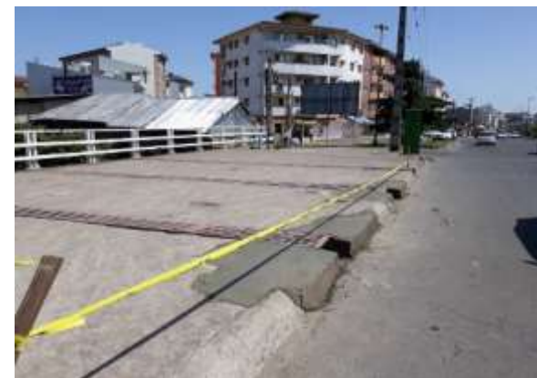
عکس بعد از اجرا
