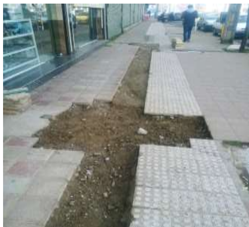
عکس قبل از اجرا
