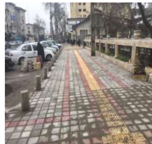
عکس بعد از اجرا
