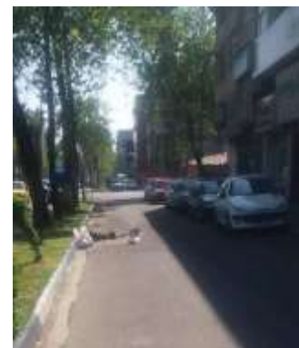
عکس بعد از اجرا
