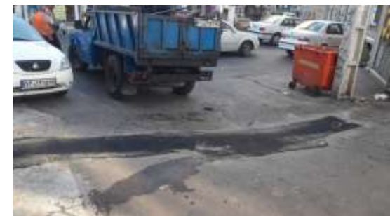
عکس بعد از اجرا
