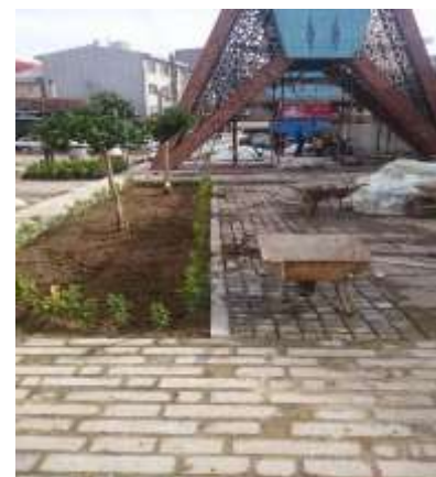
عکس بعد از اجرا
