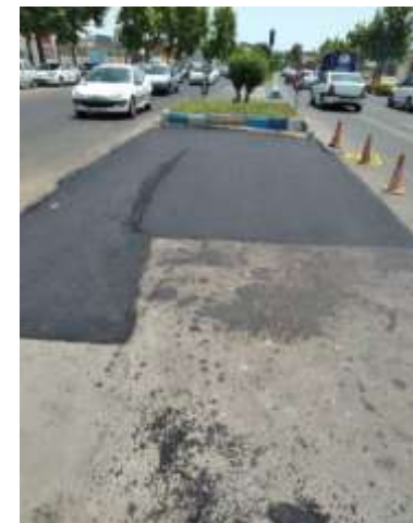
عکس بعد از اجرا
