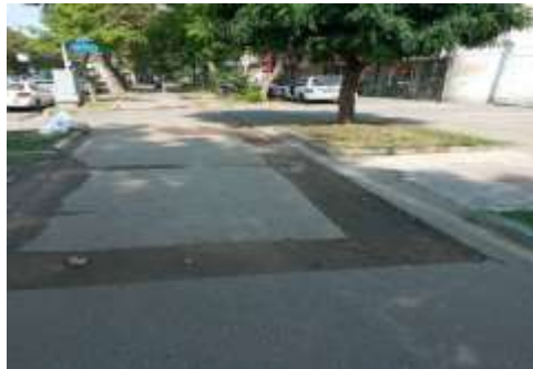
عکس قبل اجرا
