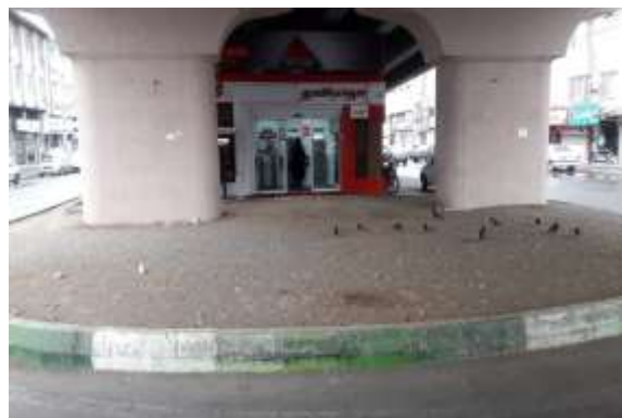
عکس قبل اجرا
