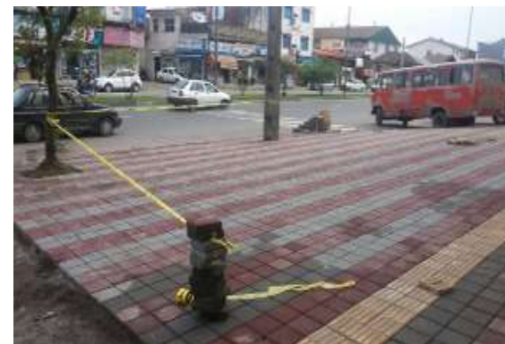
عکس بعد از اجرا
