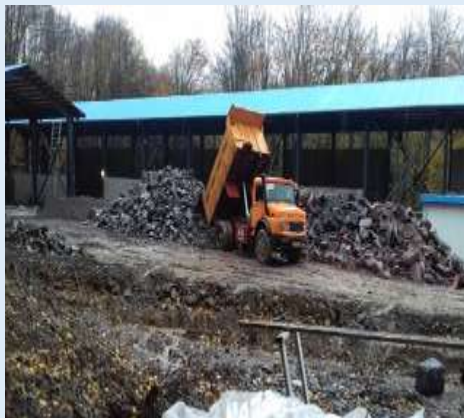
تصاویر اجرای پروژه/ وضعیت کنونی
