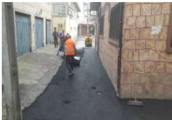
عکس قبل از اجرا
