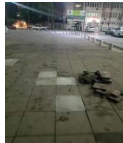
عکس بعد از اجرا
