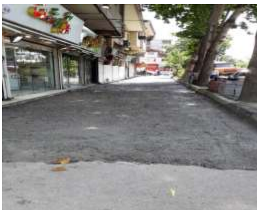
عکس قبل از اجرا
