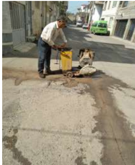
عکس قبل اجرا
