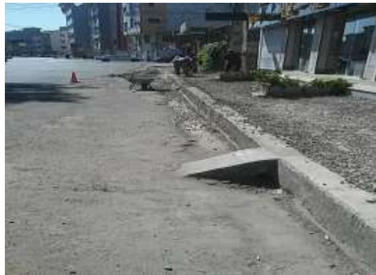
عکس قبل از اجرا
