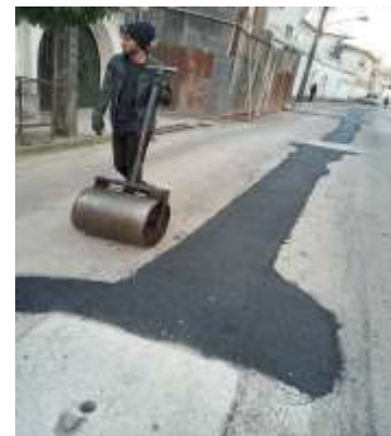
عکس بعد از اجرا
