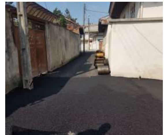
عکس بعد از اجرا
