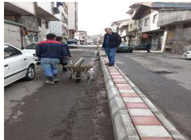
عکس بعد از اجرا
