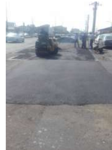
عکس بعد از اجرا
