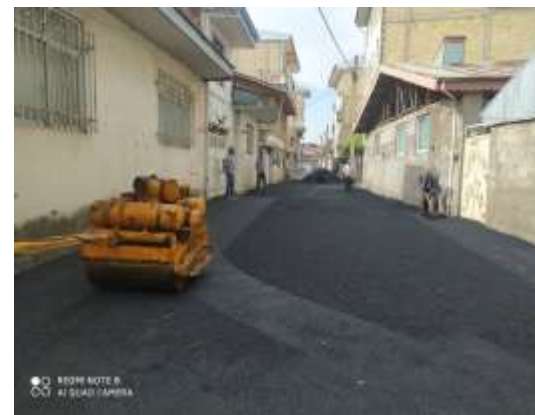
عکس بعد از اجرا
