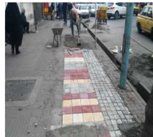
عکس بعد از اجرا
