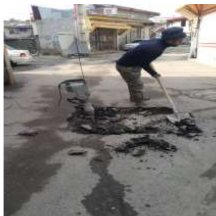
عکس قبل اجرا
