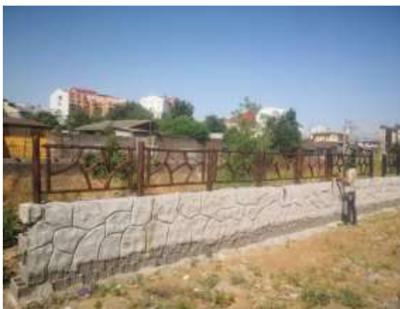
عکس قبل اجرا
