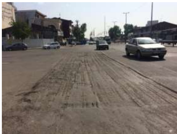
عکس قبل اجرا
