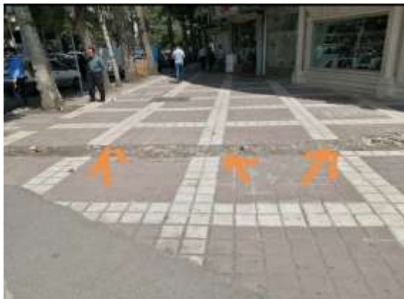
عکس قبل از اجرا
