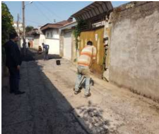
عکس قبل از اجرا
