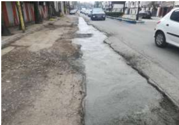
عکس قبل از اجرا
