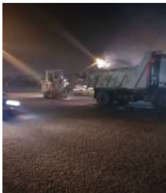
عکس قبل از اجرا
