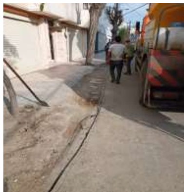
عکس قبل اجرا
