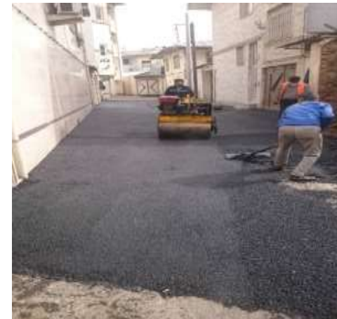
عکس بعد از اجرا
