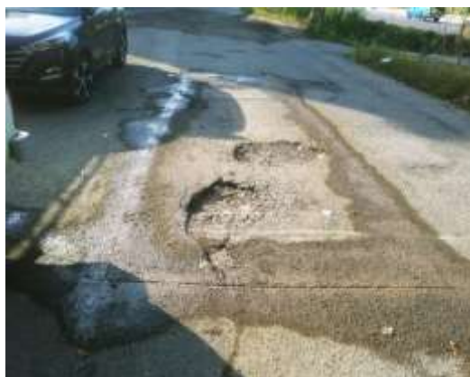
عکس قبل از اجرا
