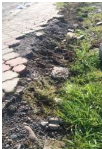
عکس قبل از اجرا
