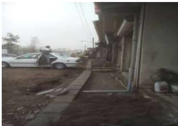
عکس قبل از اجرا
