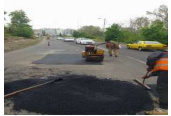
عکس بعد از اجرا
