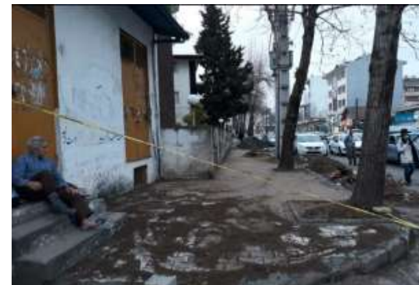
عکس بعد از اجرا
