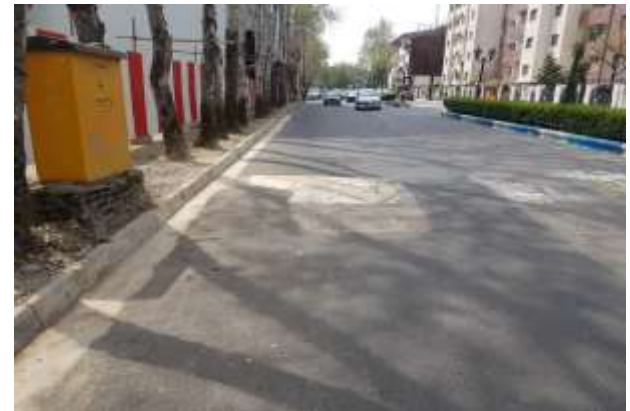
عکس بعد از اجرا
