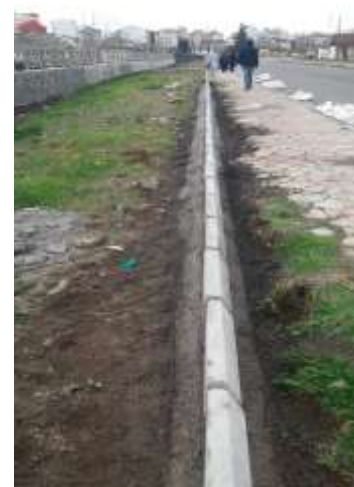
عکس بعد از اجرا
