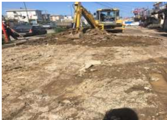
عکس قبل اجرا
