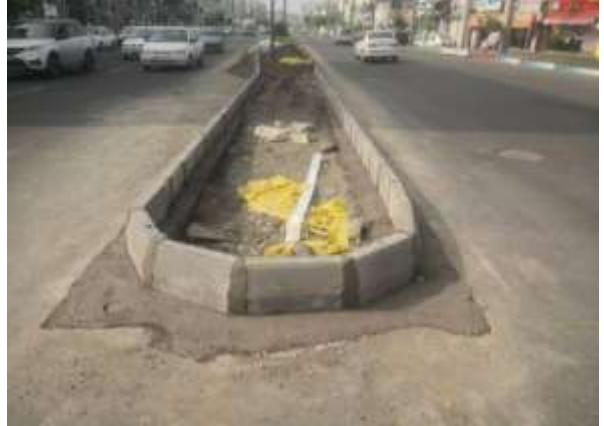
عکس بعد از اجرا
