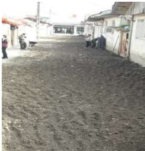
عکس قبل از اجرا
