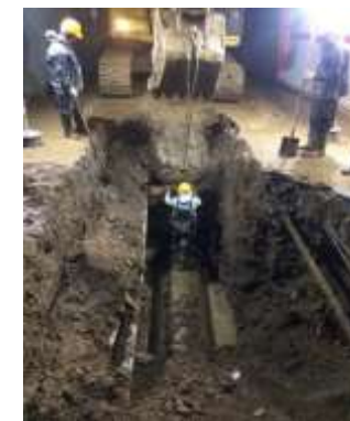
عکس بعد از اجرا
