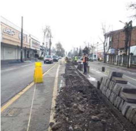
عکس قبل از اجرا
