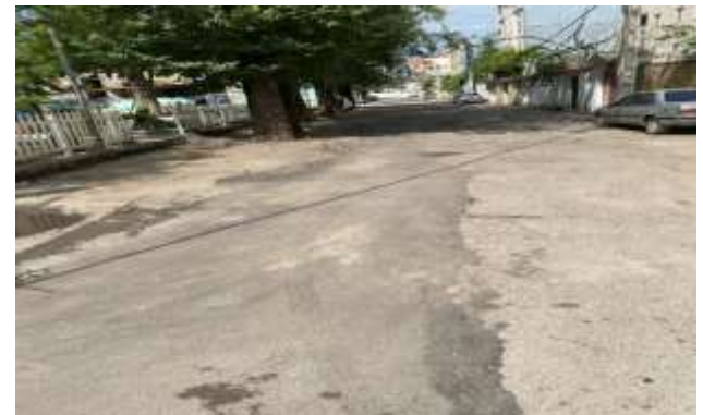
عکس بعد از اجرا
