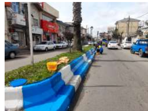
عکس بعد از اجرا
