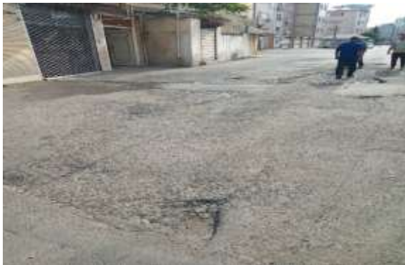
عکس قبل از اجرا
