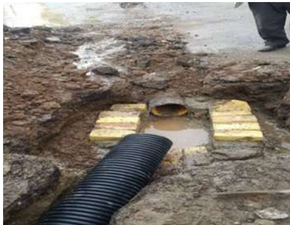
عکس قبل از اجرا
