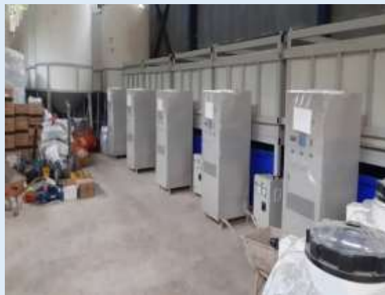
تصاویر اجرای پروژه / وضعیت کنونی
