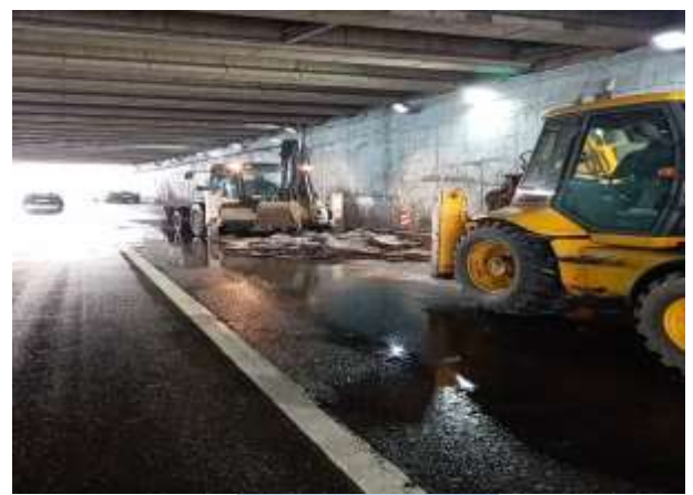
عکس قبل از اجرا
