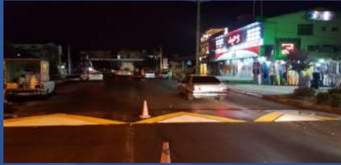
❖ اجرای انواع خط کشی عرضی در بلوار خرمشهر
