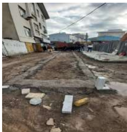
عکس قبل از اجرا
