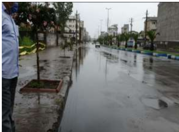
عکس قبل از اجرا
