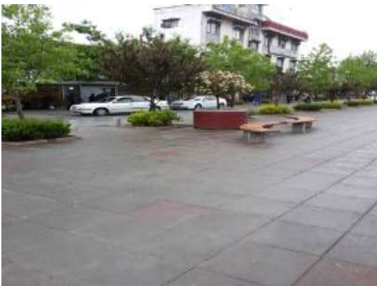
عکس قبل از اجرا
