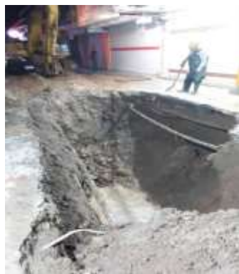
عکس قبل از اجرا
