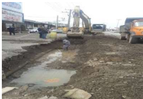
عکس قبل از اجرا
