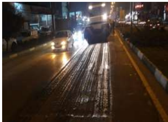
عکس قبل اجرا
