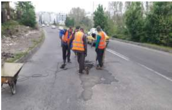
عکس قبل از اجرا
