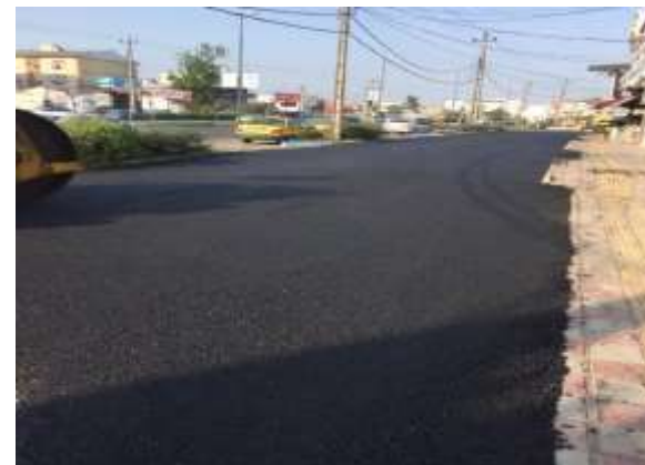
عکس بعد از اجرا
