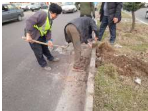
عکس قبل اجرا
