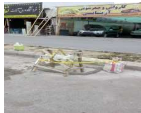
عکس بعد از اجرا
