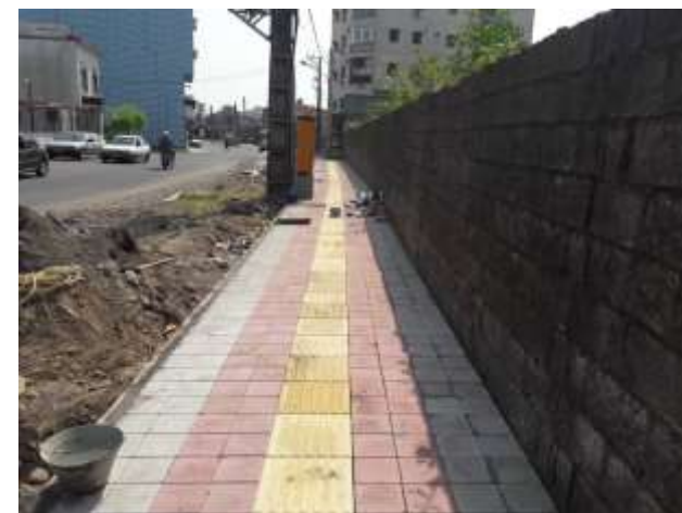
عکس بعد از اجرا
