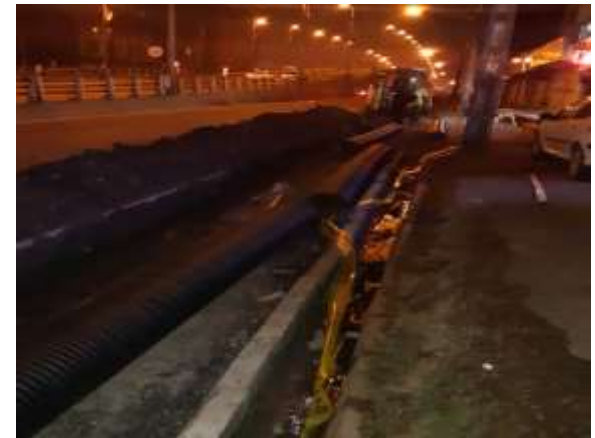
عکس بعد از اجرا
