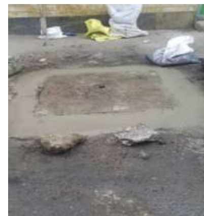
عکس بعد از اجرا
