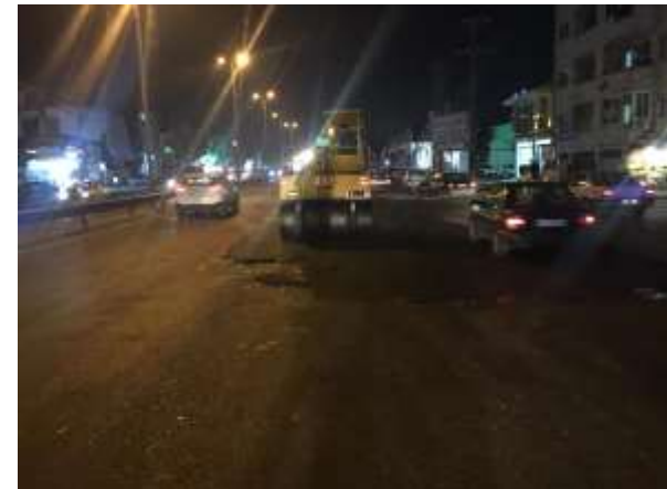
عکس بعد از اجرا
