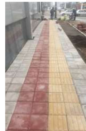
عکس بعد از اجرا
