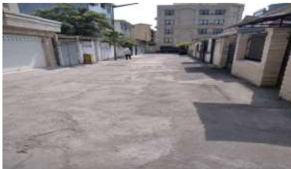
عکس قبل از اجرا
