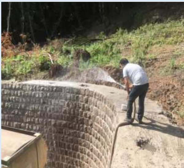
تصاویر اجرای پروژه / وضعیت کنونی
