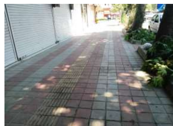
عکس بعد از اجرا
