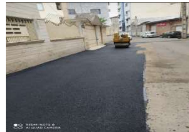
عکس بعد از اجرا
